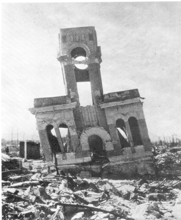
La torre dell'orologio dell'orologeria-gioielleria Shimomura, 700 metri a est del punto zero a Hiroshima. Benché solidissima e massiccia la costruzione è stata deformata in ogni sua parte, come avviene nei terremoti.
